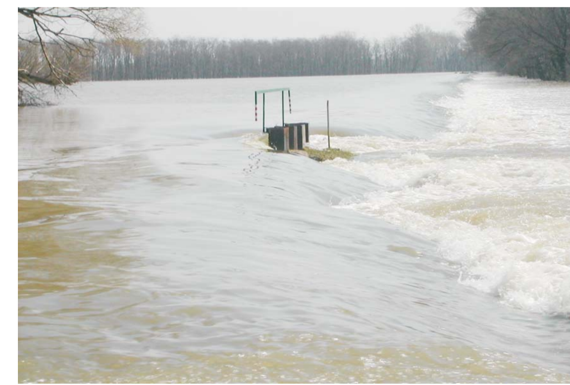
Abb. 2 und 3: Dammüberströmung und Schäden beim Marchhochwasser 2006 (Quelle: via-donau).
