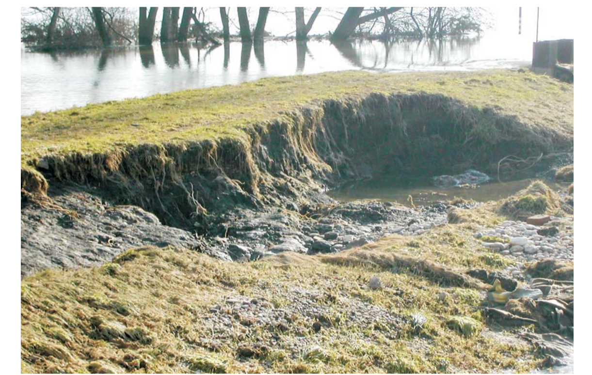
Abb. 2 und 3: Dammüberströmung und Schäden beim Marchhochwasser 2006 (Quelle: via-donau).
