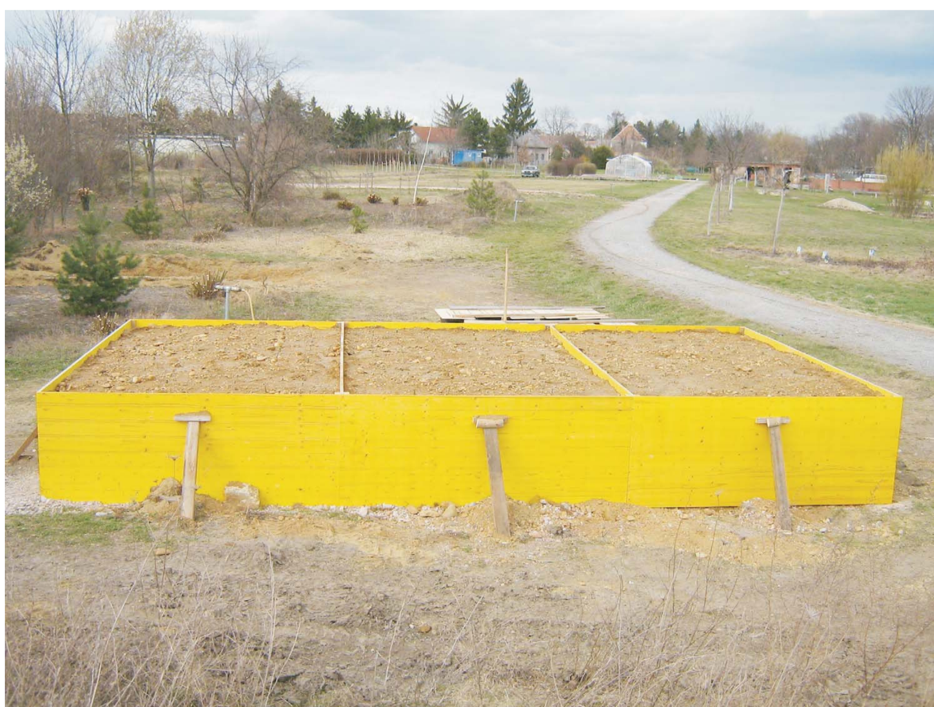
Abb. 2: Nach Fertigstellung der Versuchsanlage (April 2010)
